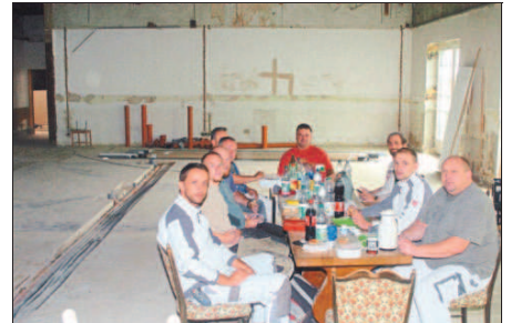
Blick in den einstigen großen Veranstaltungssaal, in dem die Bauarbeiter gerade ihre Frühstückspause machen.
