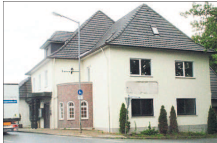
Der ehemalige Schweichelner Krug wird komplett umgebaut und heißt künftig »Unser kleines Heim mitten im Leben«.
