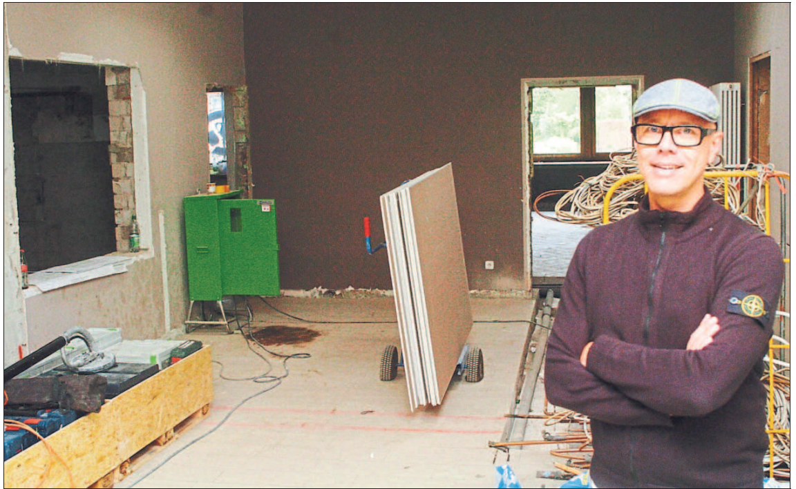
Lars Uhlen, Geschäftsführender Gesellschafter der Bonitas Holding, hat sich gestern ein Bild vom Stand der Umbauarbeiten in Schweicheln gemacht.
