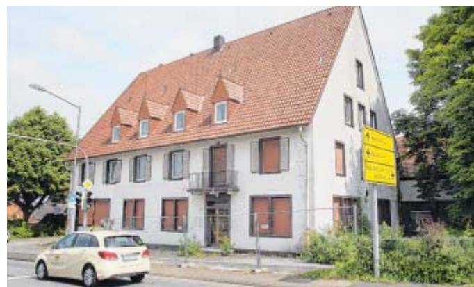
Ehrler-Gelände: Das Gebäude steht noch, so lange Schwalben noch nisten und die Ersatz-Nisthilfe nicht beschafft ist.
