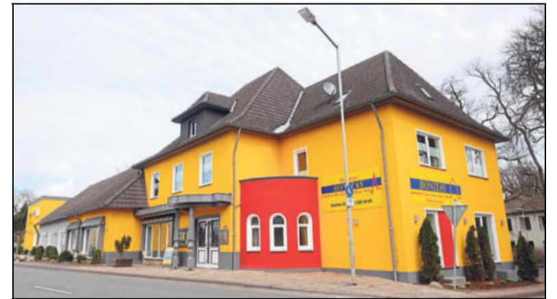
Da geht (auch farblich) die Sonne auf: Das gelbe Bonitas-Haus an der Herforder Straße ist zu einem Blickfang in Schweicheln geworden.
