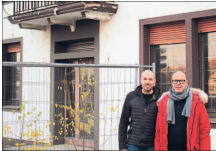
Bonitas-Geschäftsführer Lars Uhlen (rechts) und Mitarbeiter Tim Hellemann vor dem ehemaligen Hotel, das abgerissen wird.
